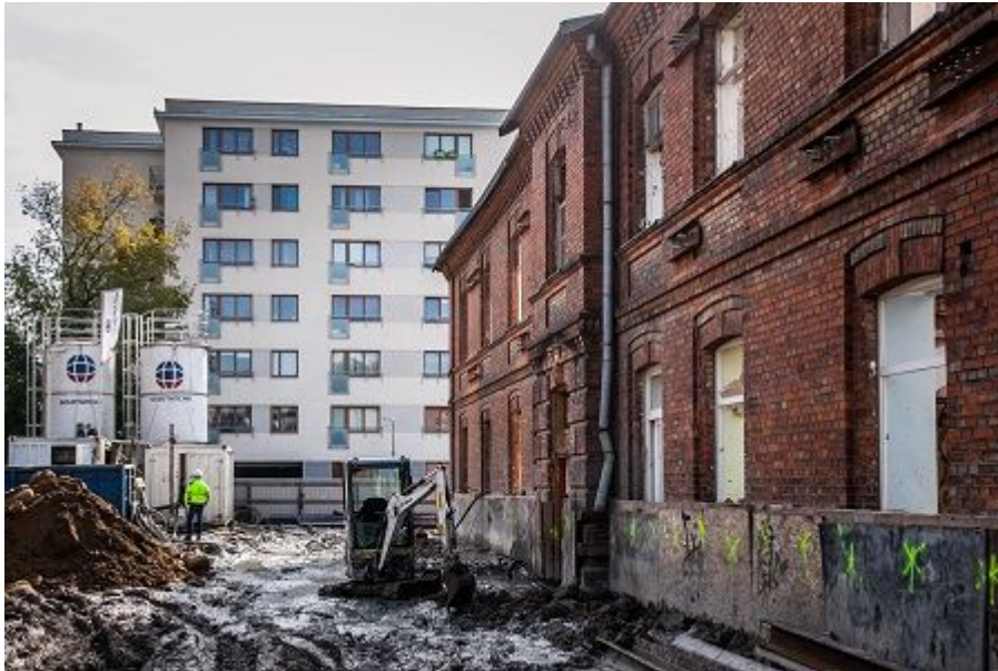
Podbicie istniejących ław fundamentowych oraz ścian istniejącego budynku. Fot. od Soletanche Polska sp. z o.o. w Warszawie
