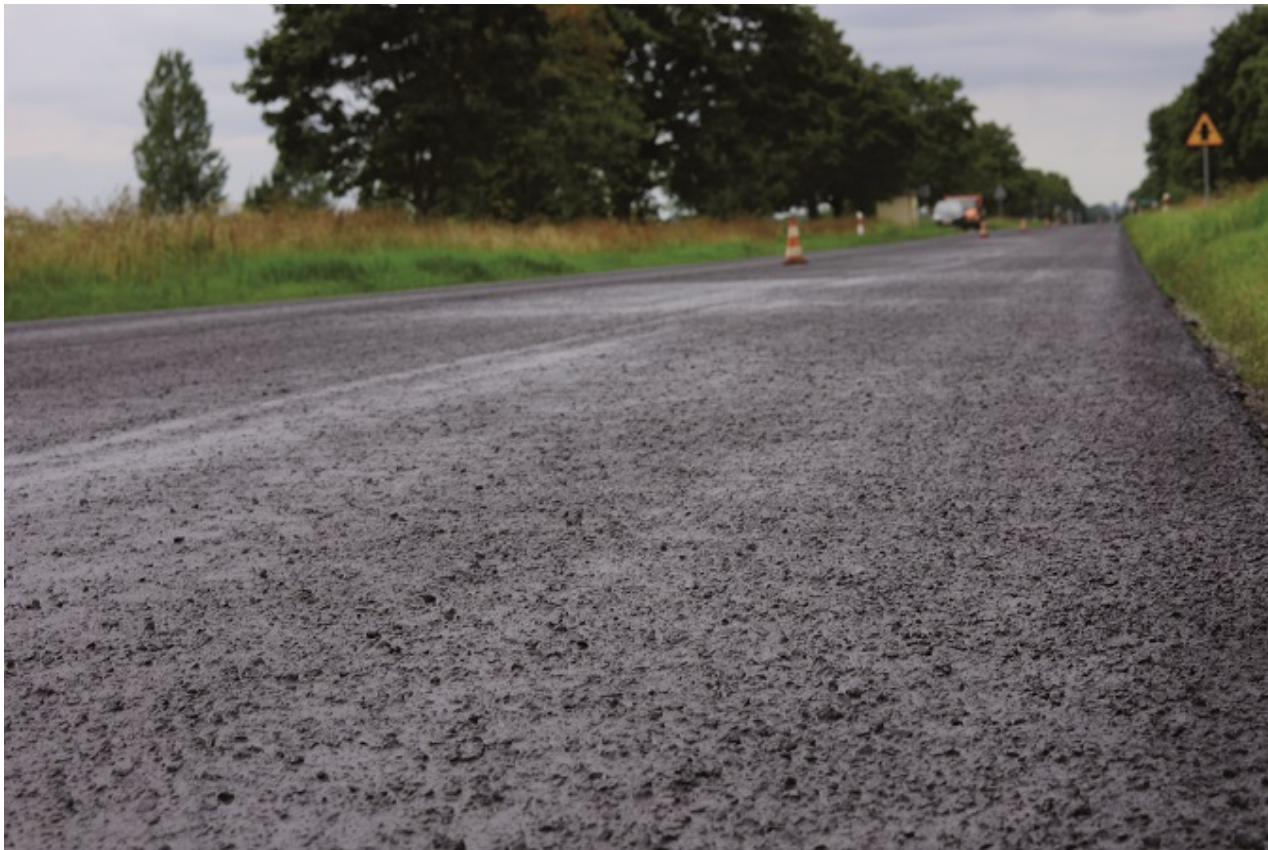
Fot. 1. Warstwa „slurry seal” (fot. Paweł Tofliński)
