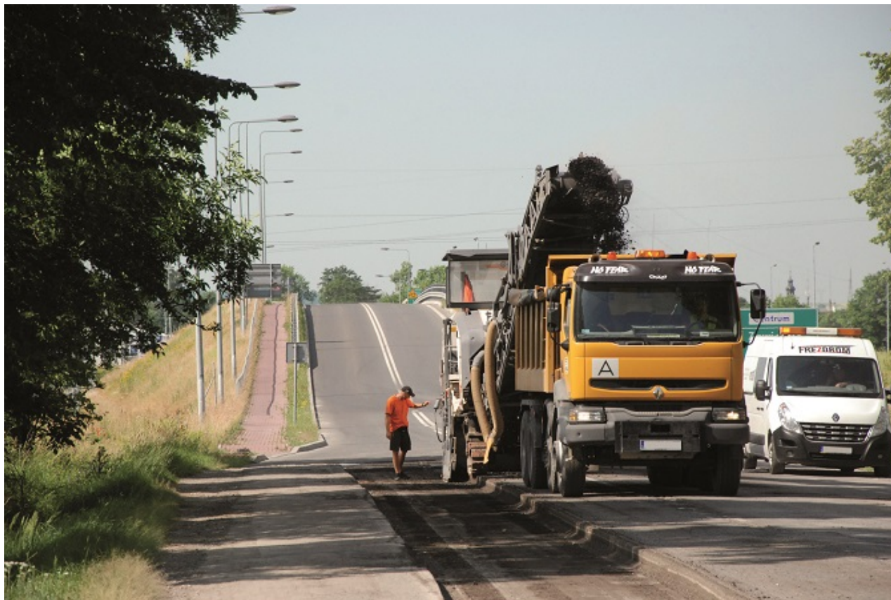
Fot. 2. Frezowanie warstw asfaltowych (fot. Andrzej Szyller)
