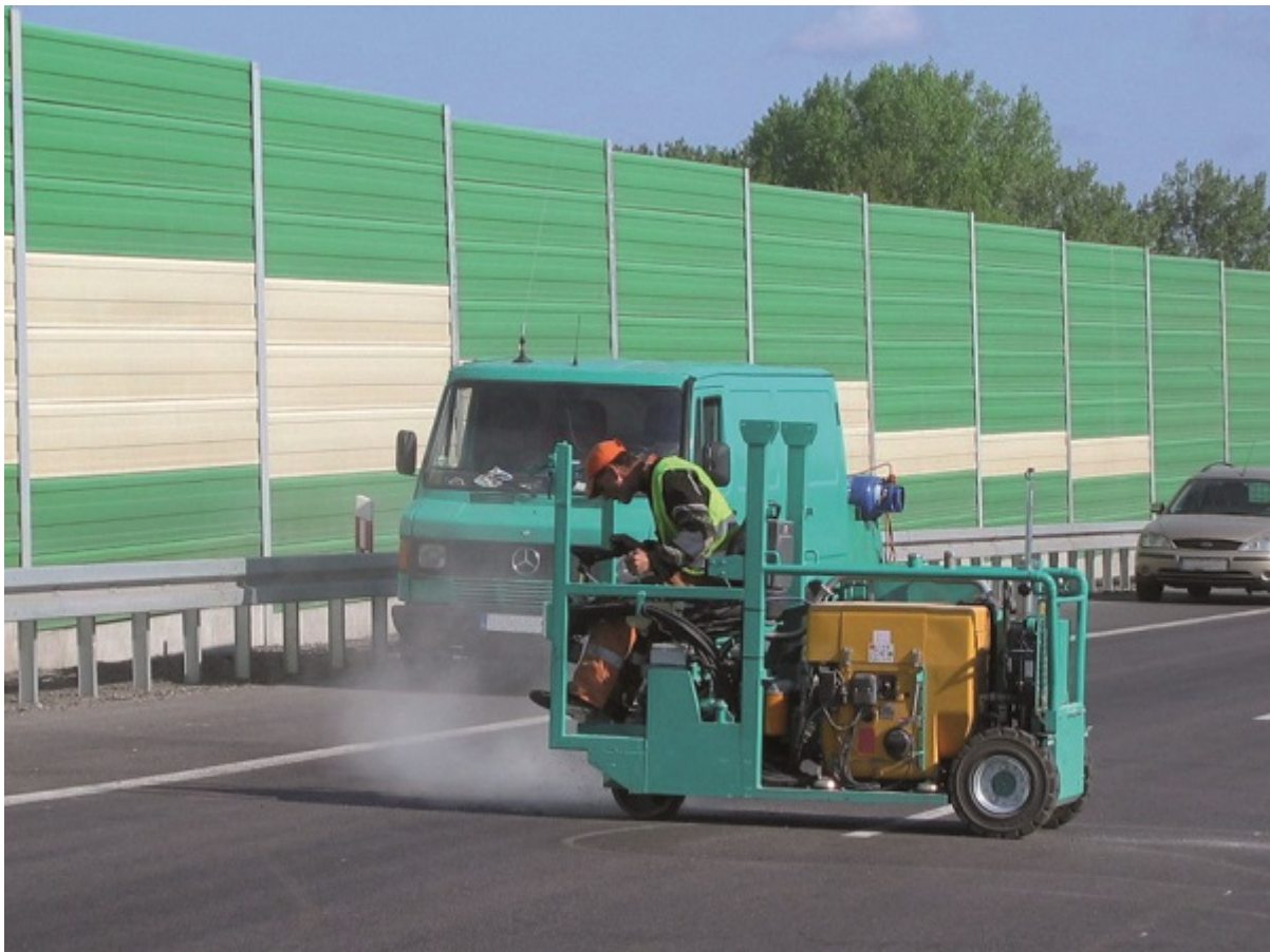
3. Frezowanie szczeliny pęknięcia [6]
