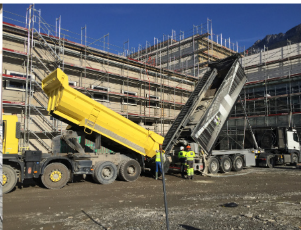
Fot.4. Produkcja jastrychu® CemFloor bezpośrednio na budowie z wykorzystaniem mobilnej naczepy „Trans-Mix”
