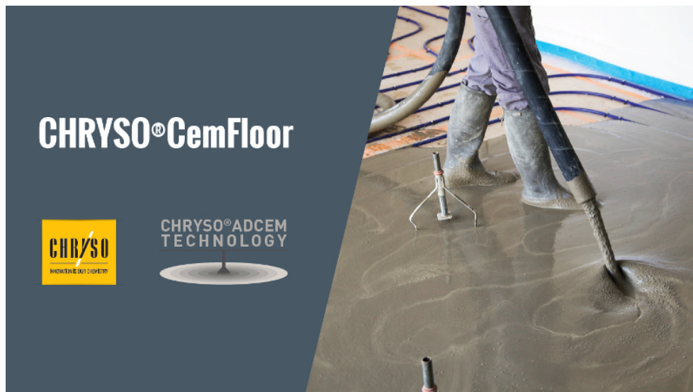
Fot.1. CHRYSO® CemFloor – płynny podkład cementowy na bazie cementu. Opracowana technologia zwiększa bezpieczeństwo i minimalizuje ryzyko powstawania pęknięć, bez konieczności stosowania włókien.
