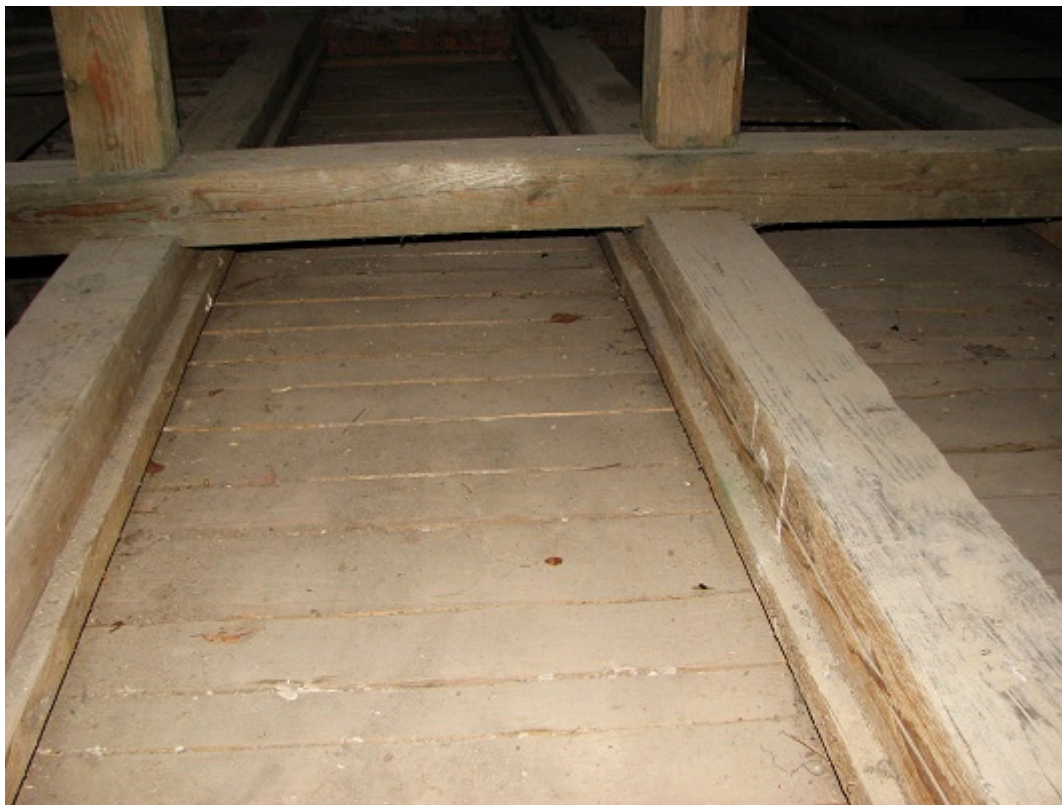
Oczyszczony strop drewniany po usunięciu polepy
