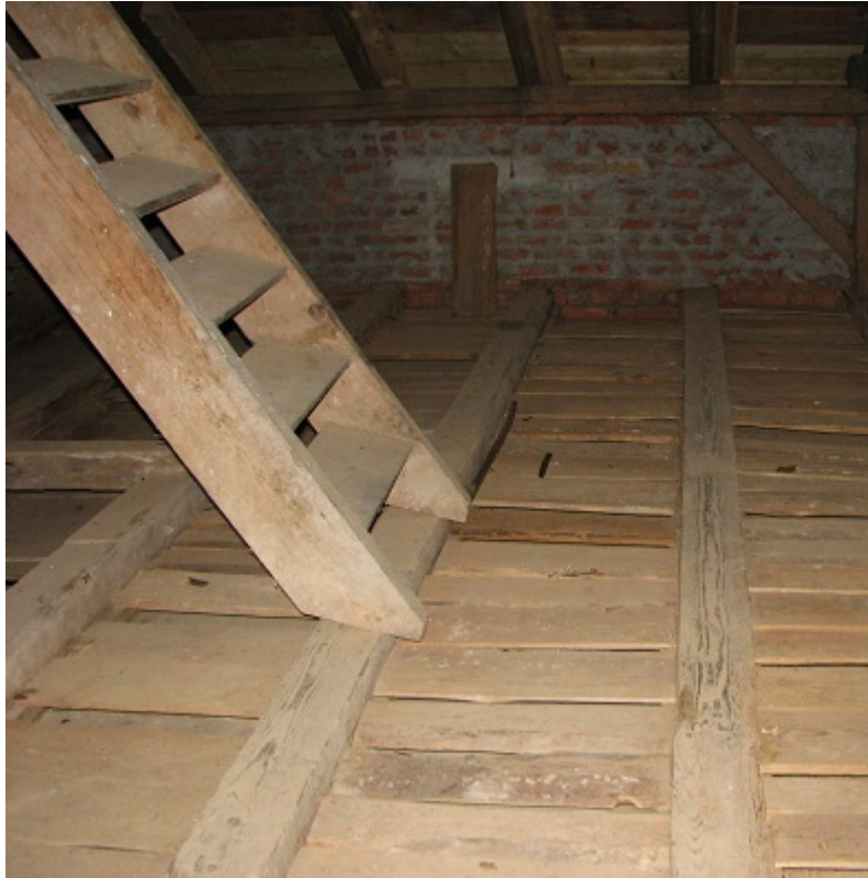
Oczyszczony strop drewniany po usunięciu polepy
