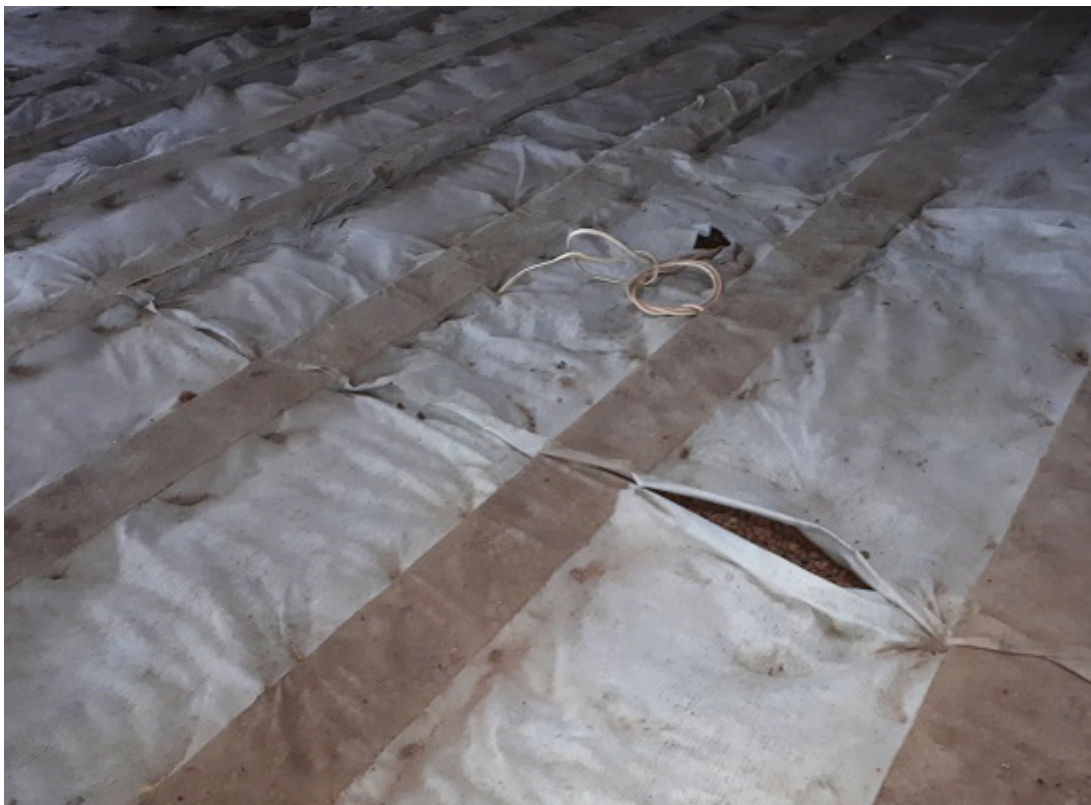
Geowłóknina separacyjna na wypełnieniu z Leca® KERAMZYTU
