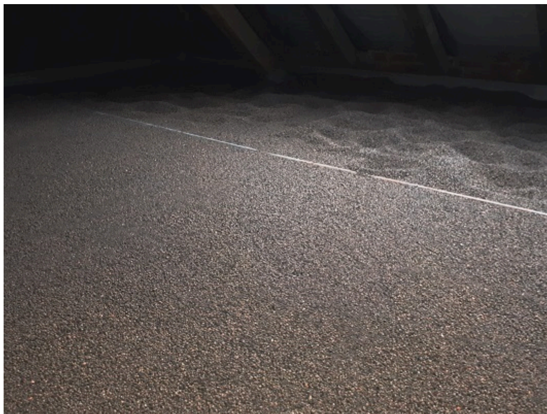
Warstwa wyrównująca z Leca® KERAMZYTU podsypkowego
