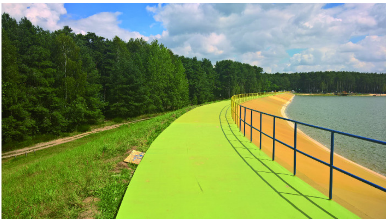
Fot. 2. Renowacja ciągu komunikacyjnego na zaporze
