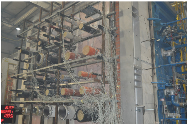
Fot. 1. Widok nienagrzewanej powierzchni elementu próbnego w trakcie badania w zakresie odporności ogniowej (uszczelnienia przejść rur do instalacji ogólnobudowlanych w ścianie)
