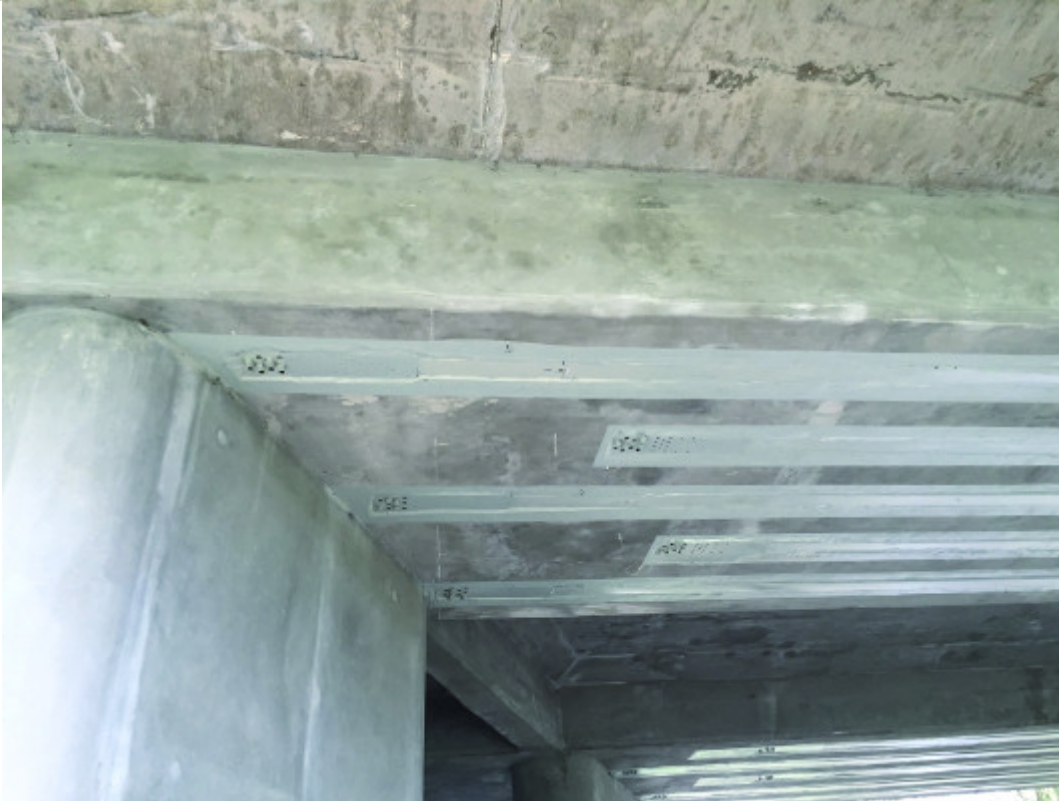
Fot. 4. Zakotwienia mechaniczne na końcach wstępnie naprężonych taśm CFRP
