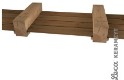
1. Belki nośne i deski ślepego pułapu (wsuwki)
