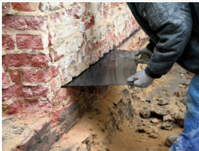
2. Wkładanie płyty izolacyjnej PE-HD
