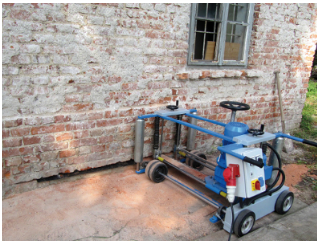
1. Cięcie ściany samojezdną piłą łańcuchową PMS
