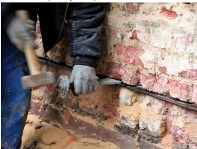
3. Wbijanie klinów zapobiegających osiadaniu ścian
