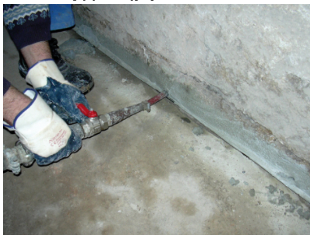
4. Właczanie pod ciśnieniem zaprawy cementowej
