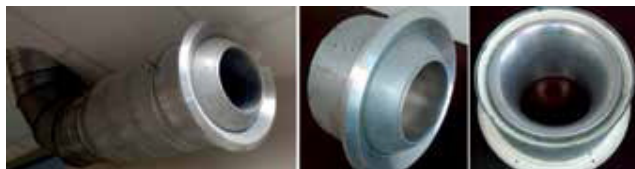
Fot. 5. Dysza dalekiego zasięgu - zamontowana na przewodzie oraz sam nawiewnik
